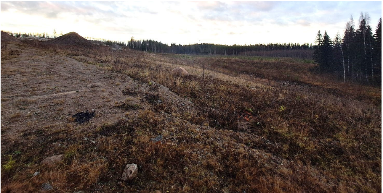
Näkymä länsiosan raivatulle ja tasatulle virkistysalueelle pohjoisesta päin kuvattuna. Vasemmalla alueelle läjitettyä maa-aineksa sekä oikealla virkistysalueen poikki toteutettu ojalinja (syksyllä 2024).
